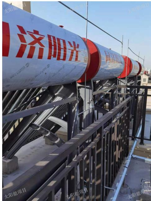
分体式太阳能热水器：在国内安装的绝大部分是紧凑式太阳能热水器。由于太阳热水器的利用主要是以建筑为载体的，紧凑式太阳热水器很不适合在屋面上安装：一是视觉效果不好，影响建筑美观；二是很难与建筑进行完美的结合；三是在屋面上安装紧凑式太阳热水器较危险，加之紧凑式太阳热水器本身无法解决的一些问题，如真空管易结垢、易炸管碎管、不承压、不易自动控制等，限制了它的推广和使用。分体式（包括壁挂式）太阳能中央热水系统是综合节能环保系统，集热器适合于多种建筑风格，安装位置多样化，成为建筑美学的点缀，符合国家对“绿色节能建筑”的政策要求，是城市节能建筑不可或缺的技术，是房地产商理想的配套产品，可以为家庭和商务生活提供舒适的生活形态。未来几年，集中供热工程会成为太阳能销售的主要方式，其中，分体式太阳能中央热水系统会在经济收入较高的消费群体中逐步普及
